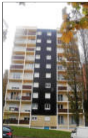
Le bâtiment comprend un rez-de-chaussée avec 40 caves et dix niveaux de quatre appartements.
